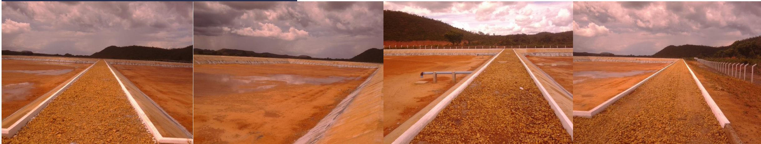
Lagoa de Estabilização em Santa Filomena/PE
