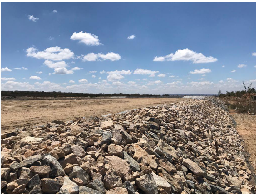
Reservatório de água bruta
