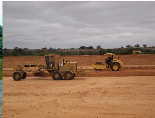
Motoniveladora e Rolo Compactador
