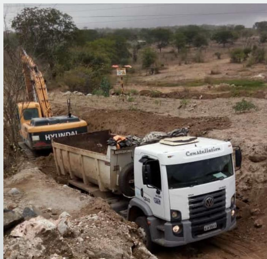
Caminhão Traçado e Escavadeira zoton Hyundai
