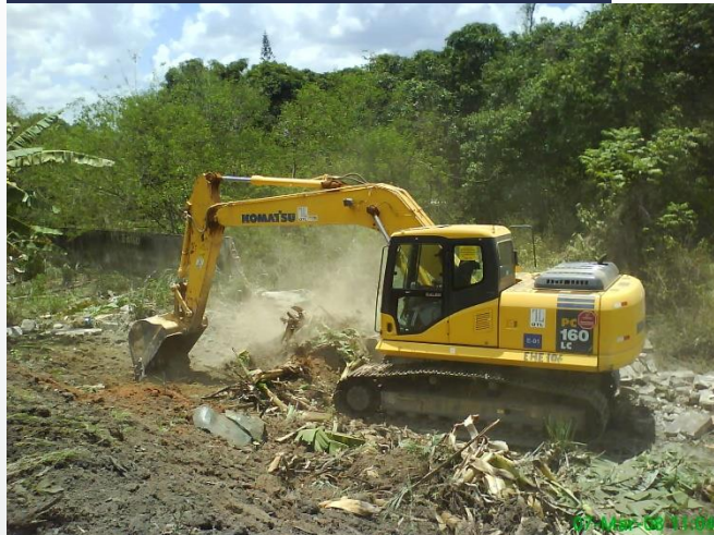
Escavadeira Hidráulica 16ton PC160
