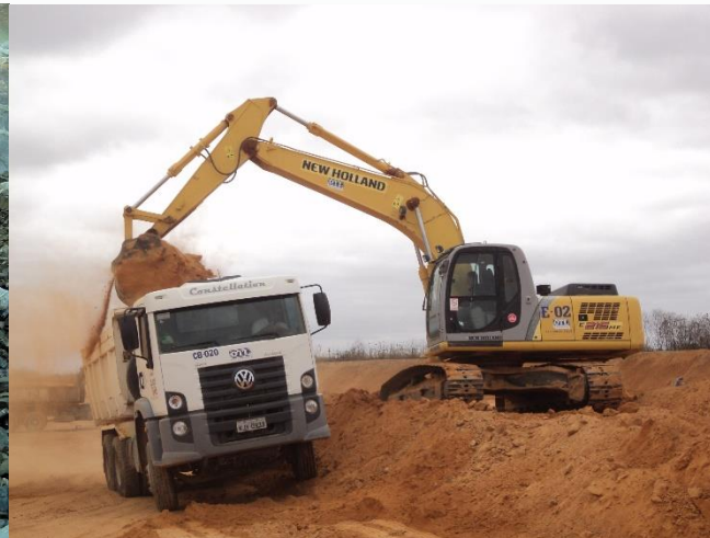
Escavadeira Hidráulica 22ton E215ME com caminhão traçado
