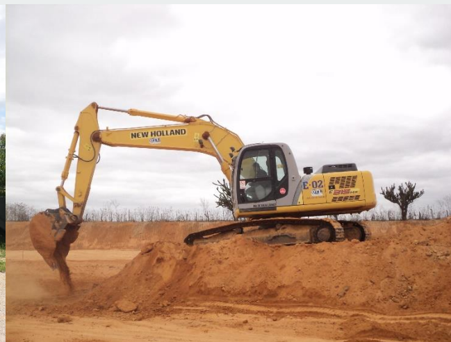
Escavadeira Hidráulica 22ton
